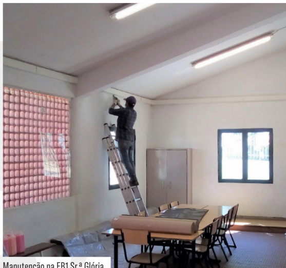
Manutenção na EB1 Sr.ª Glória
